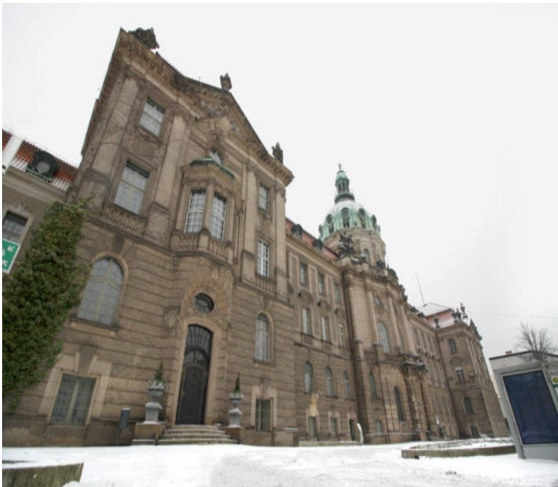
@: LHP/ Frank Daenzer https://kis-potsdam.de/artikel/aktueller-%C3%BCberblick-bauarbeiten-rathaus-potsdam
