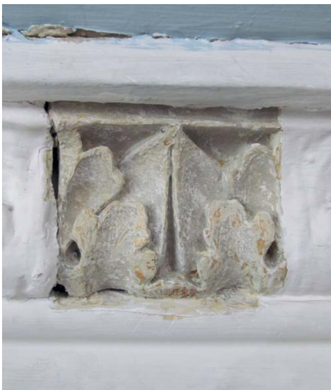
93 Freilegung der Erstfassung des Stuckgesimses. Foto: Tjalda Eschebach, 2016.
