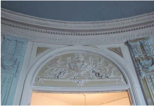
89 Lünettenfeld oberhalb des nordöstlichen Nischeneingangs. Foto: Tjalda Eschebach, 2016.
