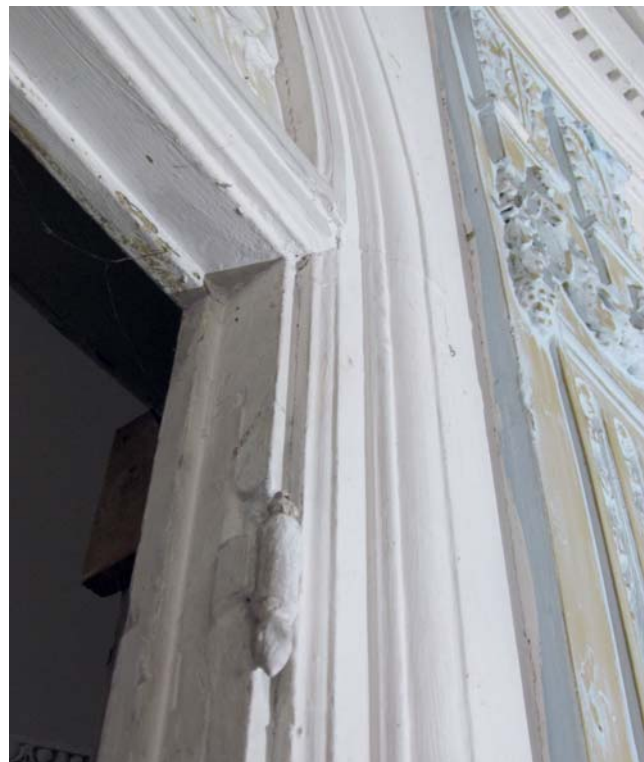
94 Scharnierband am Rahmen eines Durchgangs zur Nische. Foto: Tjalda Eschebach, 2016.
