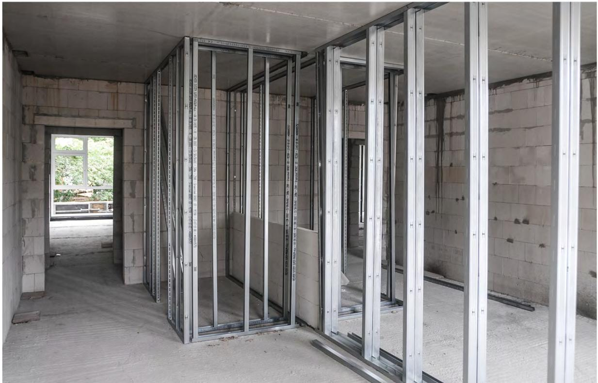
Foto 38: Standardapartment (rechts im Bild Trockenbau für Sanitärbereich), 30.08.2018
