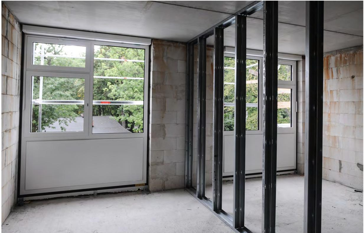
Foto 37: Standardapartment (rechts im Bild Wohnungstrennwand in Trockenbau), 30.08.2018
