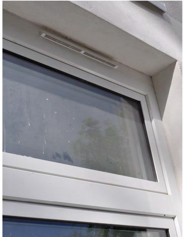
Foto 20: Schalldämmlüfter in Fensterelementen, 15.05.2019
