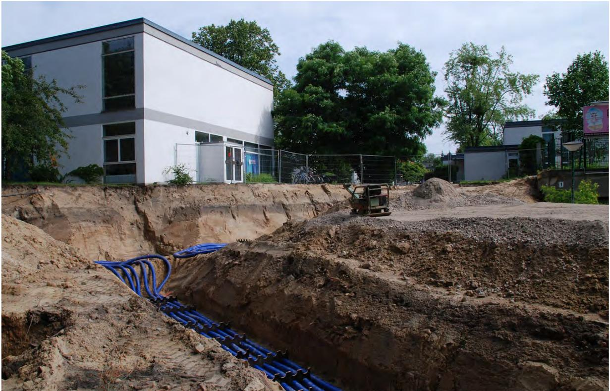
Foto 3: Baugrube zur Verlegung des Trafoanschlusses, 12.07.2017
