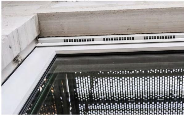
Foto 18: Schalldämmlüfter in Fensterelem., Rohbau, 30.08.2018
