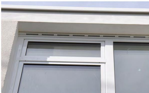
Foto 19: Schalldämmlüfter in Fensterelementen, 15.05.2019
