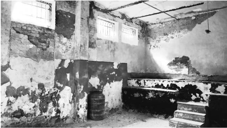
Abb. 2: Raum 0, der vormalige Desinfektionsraum, mit Blick nach Nord-Osten auf die fest installierten Becken | Foto: Tjalda Eschebach 2019
