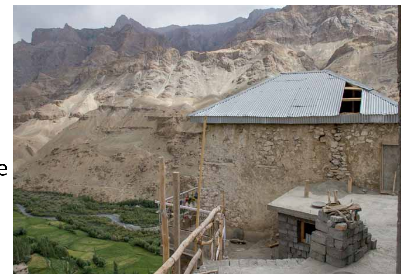
Abb. 2: Nordfassade des Nyima Lhakhang.
