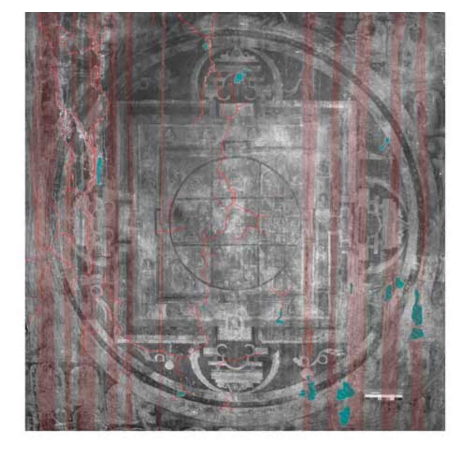
Abb. 9: Kartierung Mandala Ost: Mauerwerk und Putz
