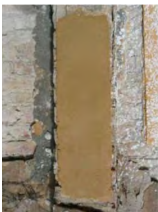
Abb. 466: Herstellung des Putzes mit Spritzbewurf
