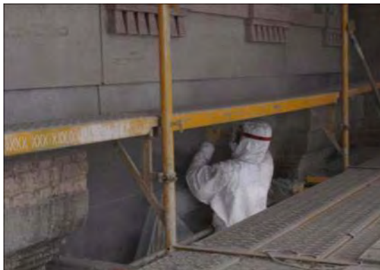
Abb. 514: Schleifen der Steinputzoberfläche mittels Winkelschleifgerät, Sanierungsarbeiten 2009/2010
