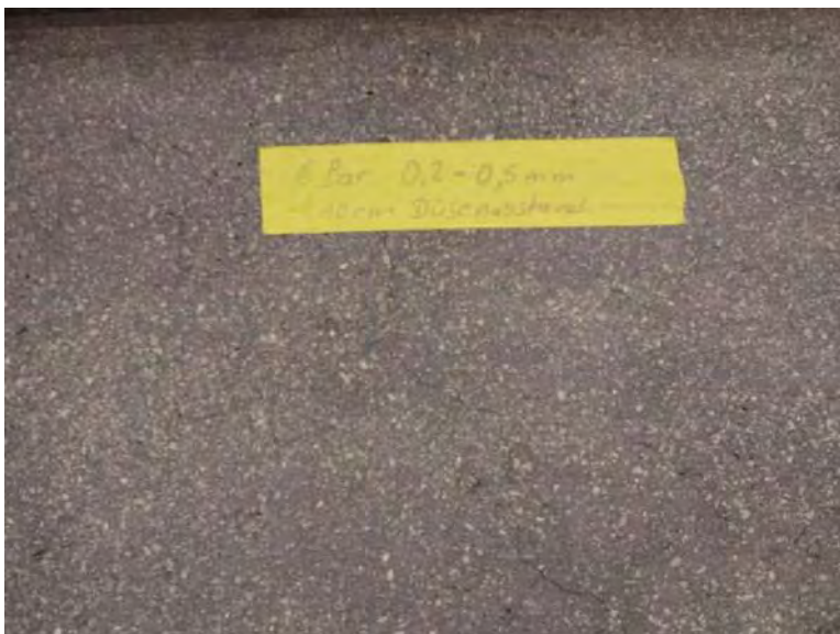
Abb. 506: Musterreinigung im Strahlverfahren mit Aluminiumsilikat 0,2-0,5 mm, 6 bar, 10cm Abstand
