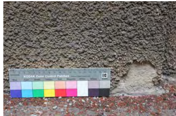
Abb. 91: Gipsbelastung führte teils zur Schollenbildung und zum partiellen Totalverlust. Wohnhaus im Dinkelsbühler Steig 6 in Berlin Fronau (→ siehe auch Kapitel Reinigung).
