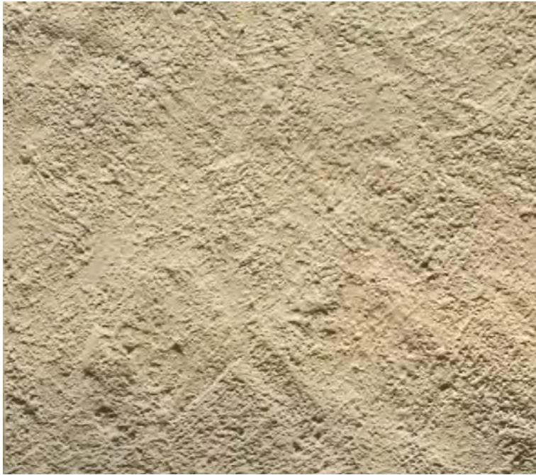
Abb. 50: Rappputz mit erkennbaren Werkzeugspuren
