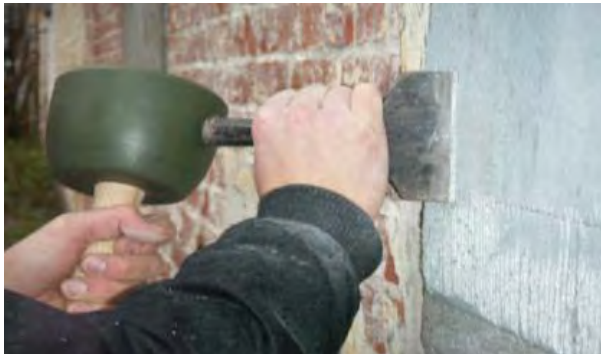
Abb. 162: Scharrieren der Probefläche
