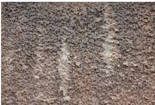
Abb. 399: Schadensbild Gipskrusten mit hellen Läufern
