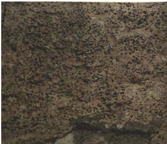
Abb. 44: Kombination aus Kellenwurf-Struktur und Rutenbesenstipp-Strukturen
