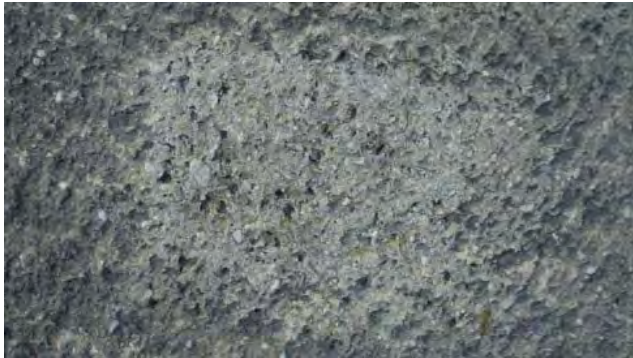
Abb. 370: Lessing-Loge, Ostfassade, mit Hirschhornsalz gereinigte Kratzputzfläche
