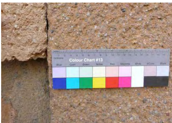
Abb. 470: Wohnhaus Potsdam, Kratzputzfläche, links im Bild nachgestellter Edelputz, rechts Originalputz in situ
