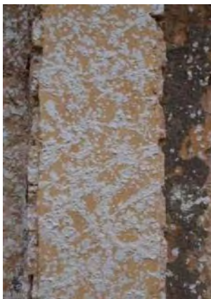
Abb. 466: Herstellung des Putzes mit Spritzbewurf
