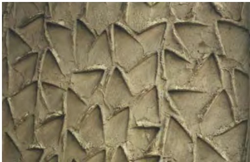
Abb. 27: Ein Kellendruckputz mittels Dreieckskelle ausgeführt
