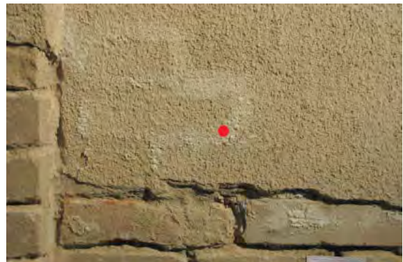
Abb. 97: Salzrasen am Mausoleum der Familie Harteneck in Stahnsdorf. (Objekt-Nr.: 4302)
