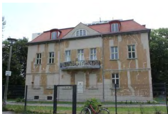
Abb. 148: Optisch stark heraus stechende Ergänzungen im großen Umfang an der Villa Schmidt, dem ehemaligen Schloss Hohenschönhausen (Bauphase) (Objekt-Nr.: 3202).
