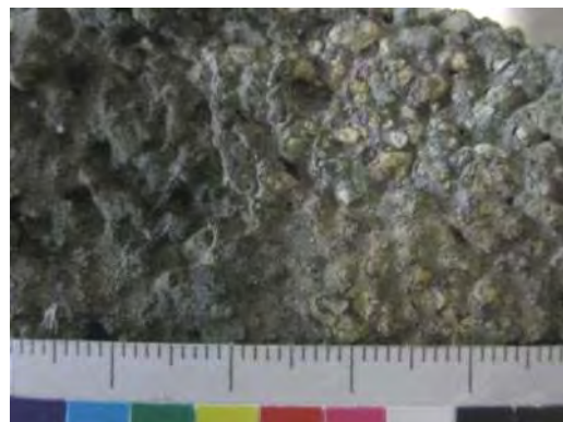
Abb. 375: Nachzustand, rechts Reduzierung der Verschmutzung zu erkennen
