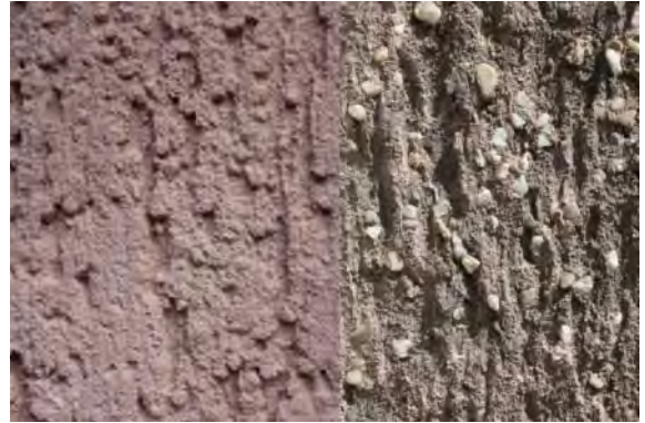
Abb. 142: Vergleich des Putzbestandes des Wohnhausblocks in der General-Barby-Straße (Objekt-Nr.: 2108) mit und ohne Fassung.
