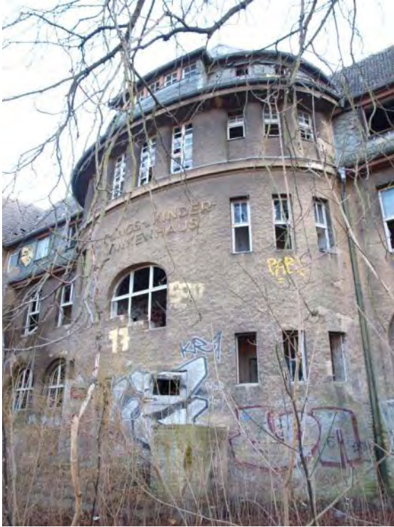
Abb. 234: Stark verschmutzter hell-ockerfarbener Edelputz am Gebäude des ehem. Säuglingskrankenhauses Weißensee
