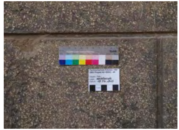
Abb. 502: Detail der Quaderung mit Scheinfugen
