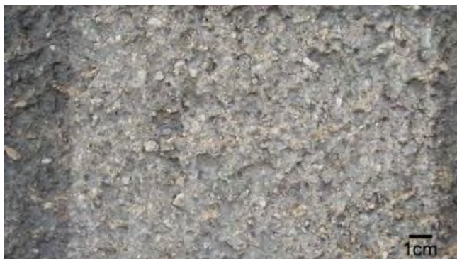
Abb. 367: Lessing-Loge, Kratzputz mit Mikrofeinstrahlgerät gereinigt
