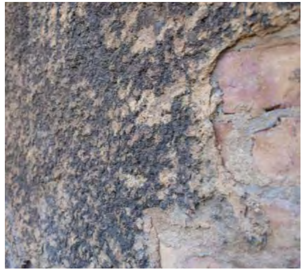
Abb. 234: Stark verschmutzter hell-ockerfarbener Edelputz am Gebäude des ehem. Säuglingskrankenhauses Weißensee
