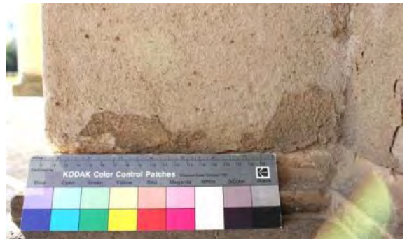
Abb. 127: Schalenbildung an der Orangerie im Park Sanssouci (Objekt-Nr.: 3103).
