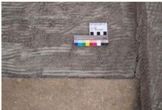
Abb. 512: Unterputz für den Steinputzergänzungsmörtel Typ C
