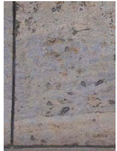
Abb. 480: Detail Südfassade NF
