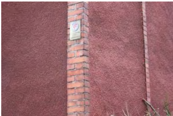
Abb. 113: Entfestigung des Putzes an der Wetterseite rechts. Die Fassade links ist sichtbar intakter. Onkel-Bräsig-Straße in der Hufeisensiedlung (Objekt-Nr.: 1200).
