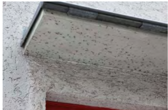
Abb. 106: Reste der Haftwurzeln und Haftscheiben nach Entfernen eines Bewuchses durch Haftwurzelkletterer, Paster-Behrens-Straße, Hufeisensiedlung (Objekt-Nr.: 1200).
