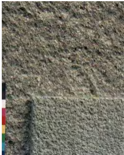
Abb. 364: Kratzputznachstellung Villa Vehse , angepasst an oberflächliche Verschmutzung
