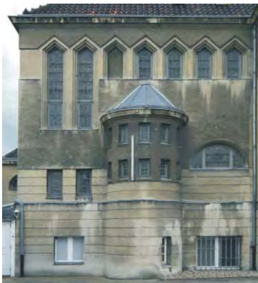
Abb. 371: Lessing-Loge, Ostfassade, vor Bearbeitung
