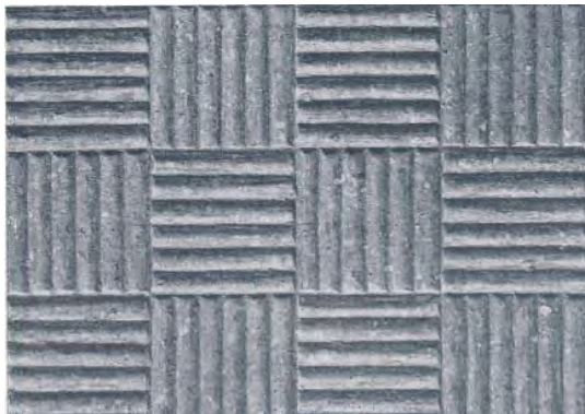
Abb. 74: Hohlkehlen schachbrettartig angelegt
