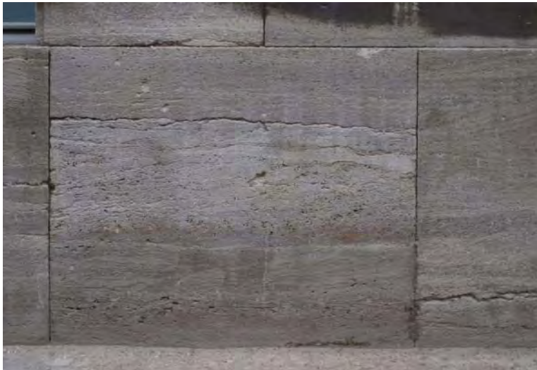
Abb. 479: Natursteinverkleidung an Nordfassade Nordflügel-Kopfbau
