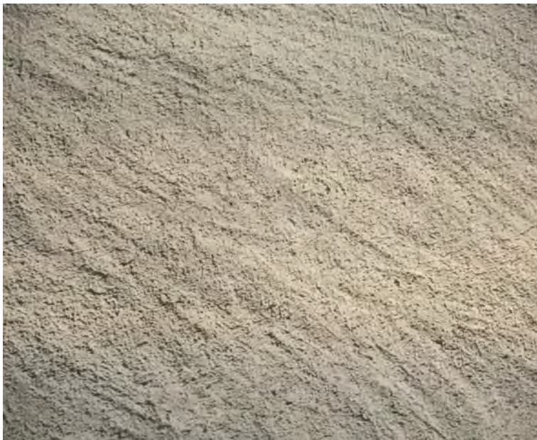
Abb. 51: leicht diagonal strukturierter Rappputz
