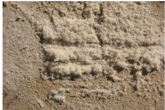
Abb. 96: Salzrasen am Mausoleum der Familie Harteneck in Stahnsdorf. (Objekt-Nr.: 4302)
