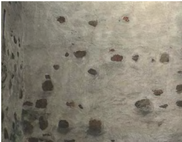
Abb. 18: Natursteinmauerwerk ist im Kellenglattstrichputzes integriert
