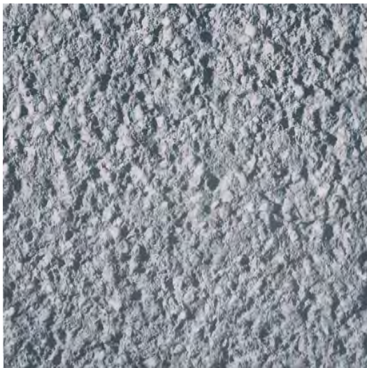
Abb. 68: Terranova - grobkörniger Kratzputz
