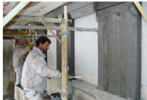
Abb. 513: Mitarbeiter der Firma K.Rogge bei der Begradigung der Putzkanten des Typs C an den Triglyphen
