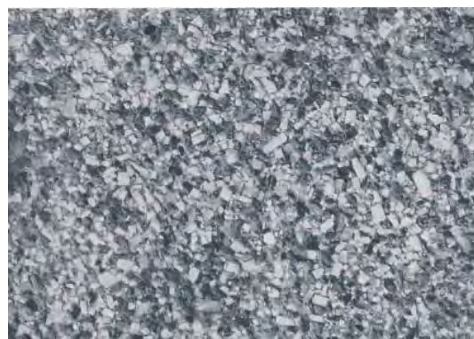
Abb. 79: Grana Waschputz mit farbl. weniger kontrast. Bindemittel-Zuschlagverhältnis
