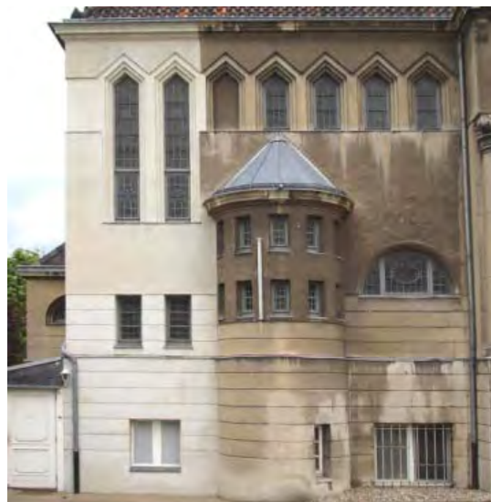
Abb. 372: Lessing-Loge, Ostfassade, mit Pilotfläche, nach 6 Monaten
