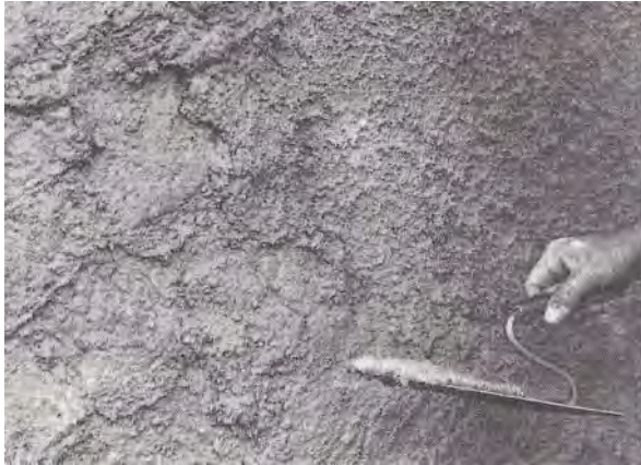
Abb. 9: Anwerfen des Mörtels mittels Kelle
