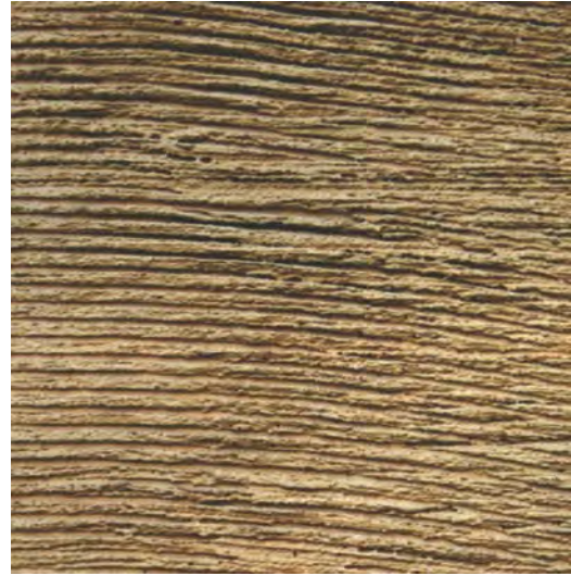
Abb. 35: horizontal gezogener Besenstrichputz
