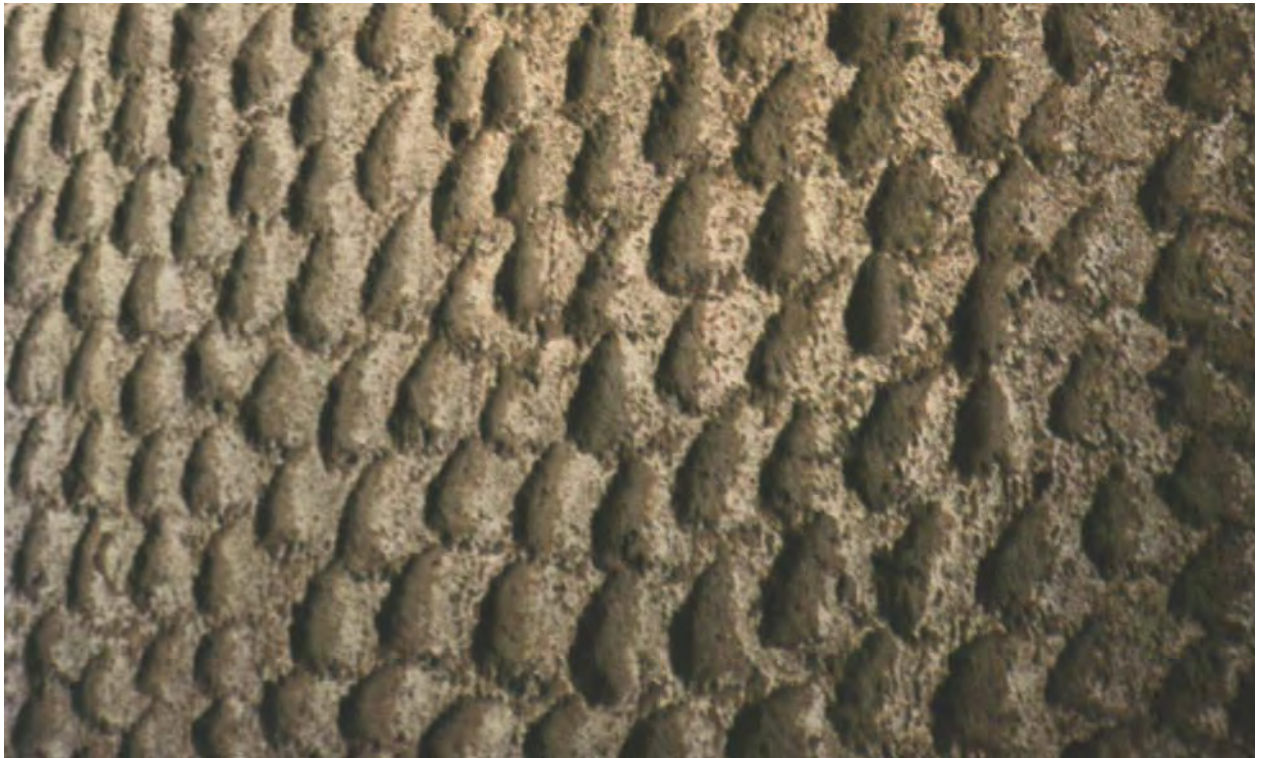
Abb. 26: Der Kellenstechputz mit seiner charakteristisch ausgehobenen Kellenstruktur
