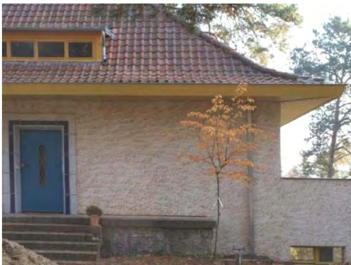
Abb. 468: Handwerkliche Nachstellung mit Werk trockenmörtel, Ausführung Ende 2010
