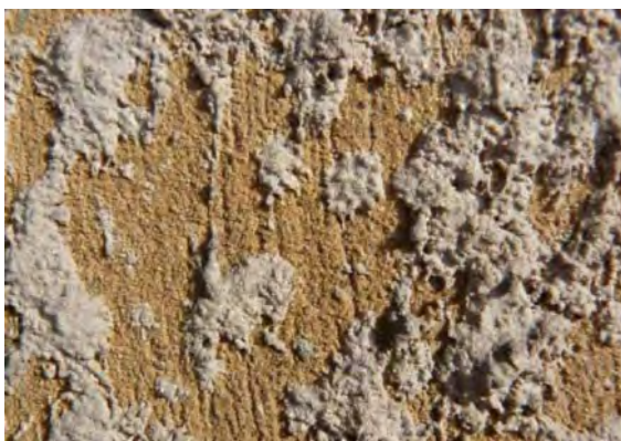
Abb. 462: Detailaufnahme des historischen Edelputzes mit Spritzbewurf
