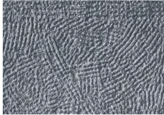
Abb. 73: mit Zahneisen bearbeitet
