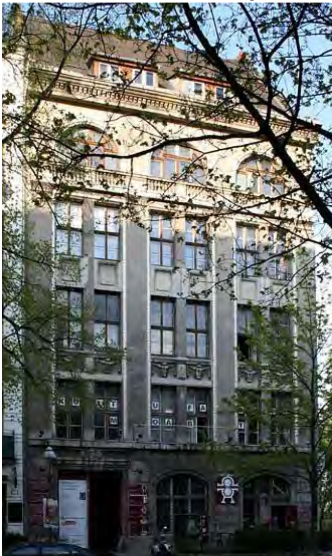
Abb. 257: Wertheim-Haus Lehrter Straße, Berlin-Moabit, rechts Schmuckelemente aus Vorsatzbeton
