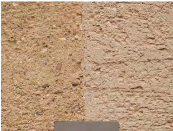
Abb. 473: Liebermann-Villa / Gärtnerhaus: links im Bild Originalputz in situ, rechts bei Sanierung 2002 nachgestellter Edelputz in situ
