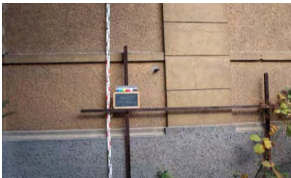
Abb. 402: Ansicht der zu bearbeitenden Wand, Vorzustand
