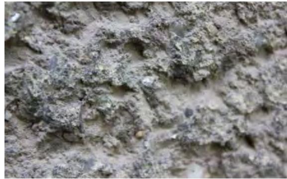
Abb. 87: Dunkle Gipskrusten mit lose aufliegenden Partikeln, Villa in der Württembergallee 24 (Obj.-Nr.: 2586).
