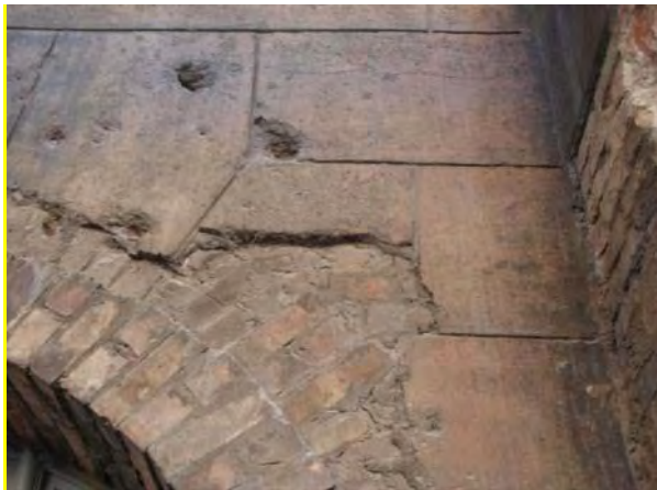
Abb. 492: Steinputz Nordfassade Nordflügel, kriegsbedingte Schäden: Ausbrüche, rötlich-braune Verfärbungen (evtl. durch Brand hervorgerufen)
