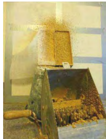
Abb. 458: Herstellen einer Probeplatte mit einer Handputzleier
