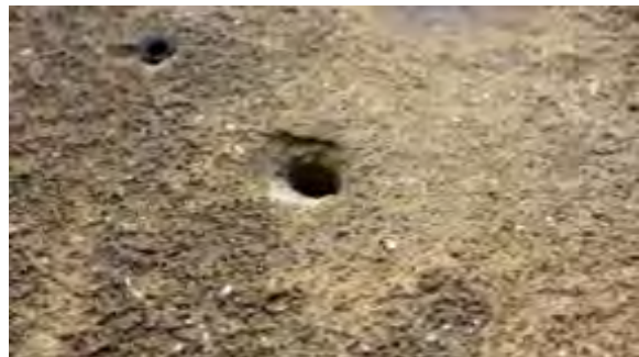
Abb.137: Bohrlöcher, teils noch mit Dübeln bestückt im Putz des Wohnhauses Schöneiche (Objekt-Nr.: 2590).
