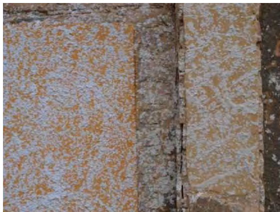
Abb. 467: Probeflächen mit Baustellenmischung
