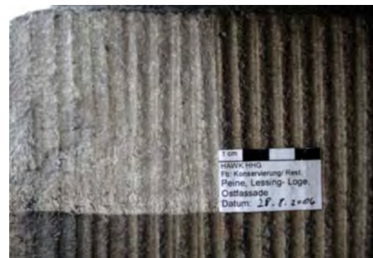
Abb. 368: Lessing-Loge, Steinputz mit Mikrofeinstrahlgerät gereinigt
