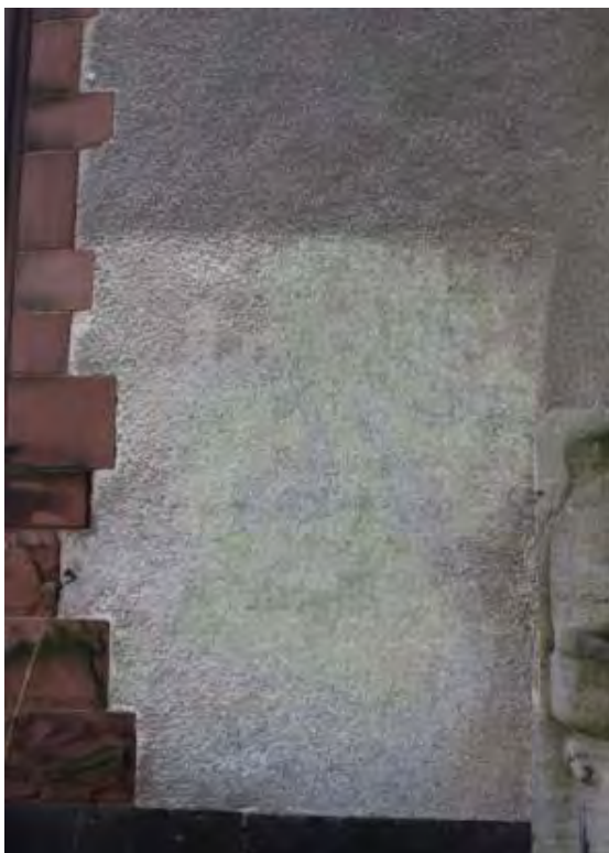
Abb. 137: Partielle Überfassung an der Johann-Peter-Hebel-Grundschule & Cäcilien-Grundschule (Objekt-Nr.: 4302).
