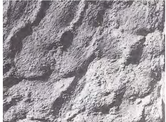
Abb. 10: Variation des Kellenwurfputzes mit eher unregelmäßiger Oberflächen-Struktur
