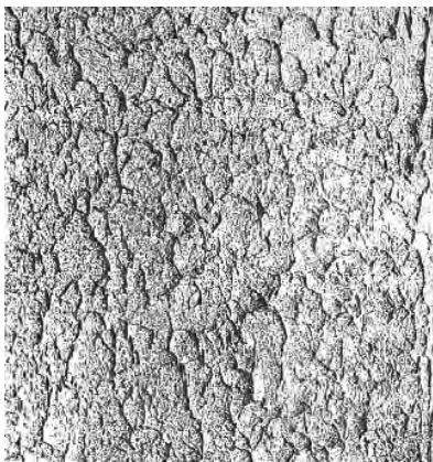
Abb. 31: typische Oberflächenwirkung eines Patschputzes
