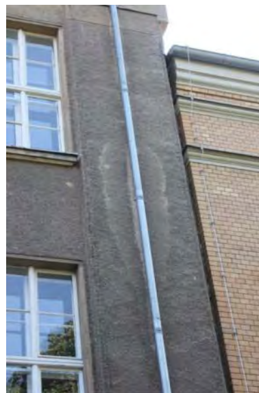
Abb. 121: Deutlich erkennbar ist hier die Auswirkung der Feuchtigkeitsbelastung durch das Wasserableitsystem in der Guerickestraße (Objekt-Nr.: 6107).
