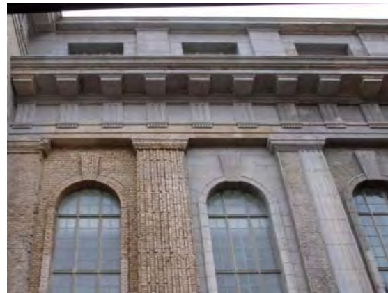
Abb. 517: Triglyphenfries nach Abschluss der Arbeiten 2010.
