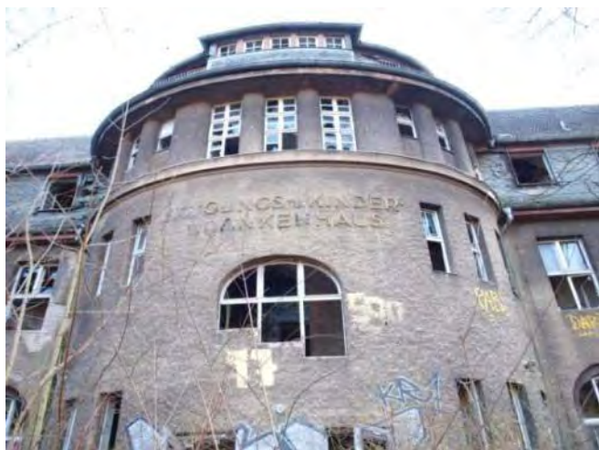
Abb. 150: Das Säuglingskrankenhaus in der Hansastrasse zeigt ein umfangreiches Spektrum an Schadensbildern am Putzbestand. Zu erkennen sind beispielsweise Verschwärzungen, Fehlstellen, Absandende Bereiche und Graffiti
