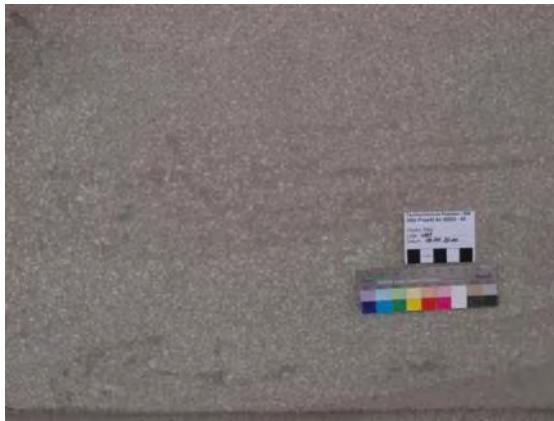
Abb. 516: Oberflächenbearbeitung, Nachstellung der Natursteintextur im Ergänzungsputz Typ C
