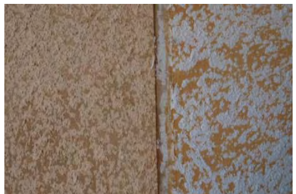
Abb. 463: Probeflächen mit Werk trockenmörteln
