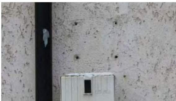
Abb.136: Alte Bohrlöcher in einer Fassade der Dörchlächtingstraße der Hufeisensiedlung, (Objekt-Nr.: 1200).
