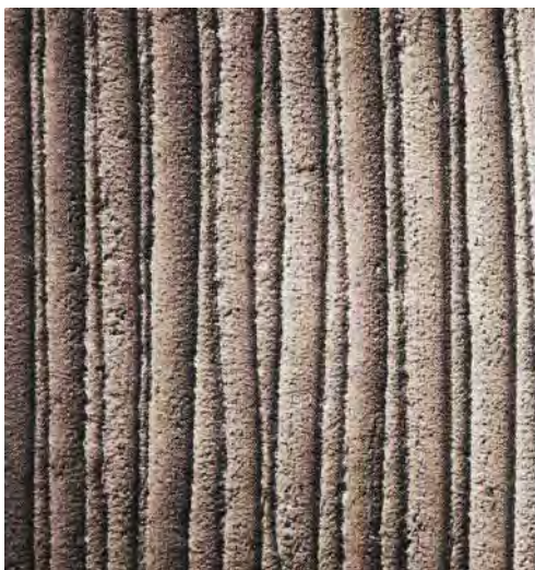
Abb. 38: Mit Gummikamm gezogener Putz
