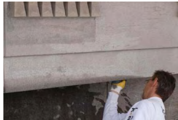
Abb. 515: anschließender Feinschliff mit Schleifsteinen, Sanierungsarbeiten 2009/2010.
