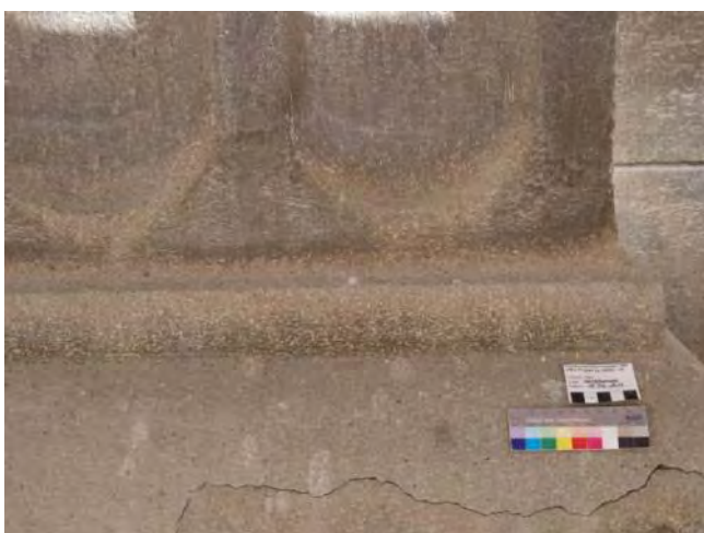
Abb. 497: Steinputz Nordfassade Nordflügel Pilasterreihe, Auswaschungen mit hell hervortretenden Kalksteinzuschlägen, oben Krustenbildung erkennbar. Unten im Bild konstruktionsbedingter Riss mit Hohlage
