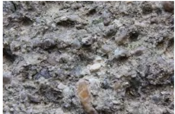
Abb. 414: Scholle 6 Detailaufnahme Vorzustand
