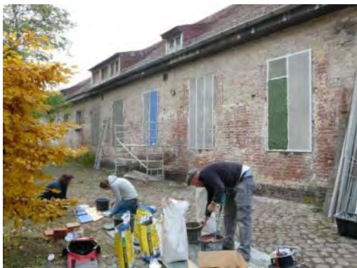
Abb. 153: Musterfelder am Casinogebäude der FHP
