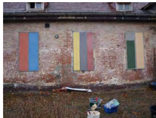
Abb. 156: Edelputzmuster am Casinogebäude der FHP
