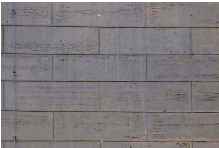
Abb. 481: Steinputzfassade mit Fugenschnitt an Nordfassade Mittelbau Nord
