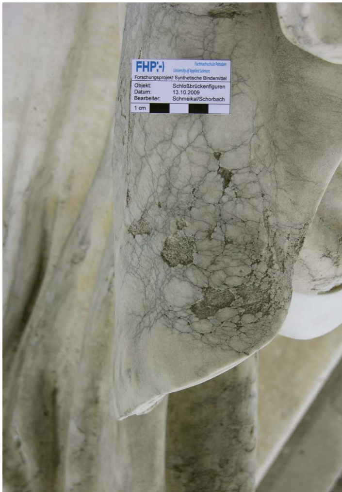
Abb.3: Detail der Schlossbrückenfigur Nr.4: Krakeleeartige Rissbildung.
