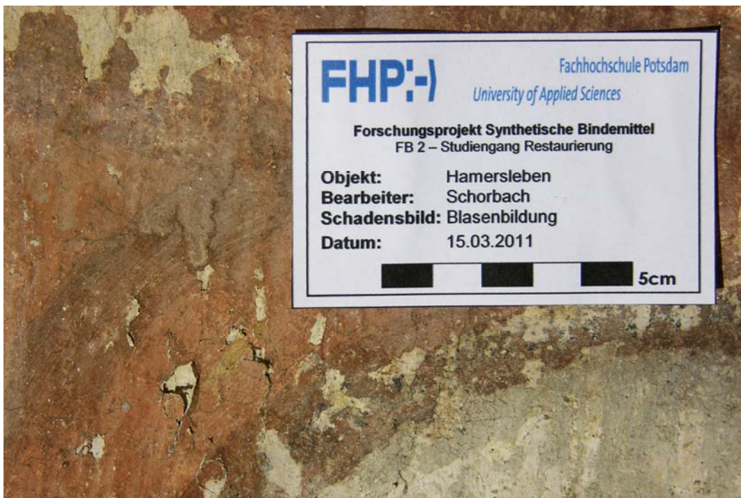
Abb.2: Blasenbildung als Schadensbild an der Wandmalerei in Hamersleben.
