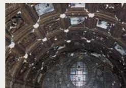
Die als Tonne ausgeformte Kassettendecke über dem Mittelschiff (Foto: ProDenkmal)
