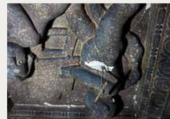
Ausschnitt mit Putten, verrußte Oberfläche und Abhänger der Rabitzkonstruktion, Tonne (Foto: ProDenkmal)
