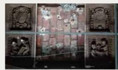
Gegossene Module im Seitenschiff Nord mit Fehlstelle und Sicht auf Teile Rabitzkonstruktion und Decke aus Ziegel
