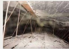
Der Rücken der Tonne mit der Rabitzkonstruktion durch ein Loch fotografiert (Foto: ProDenkmal)
