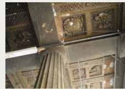
Ausschnitt der Kassettendecken über Mittel- und Seitenschiff, Säule und Deckenbalken aus Travertin
